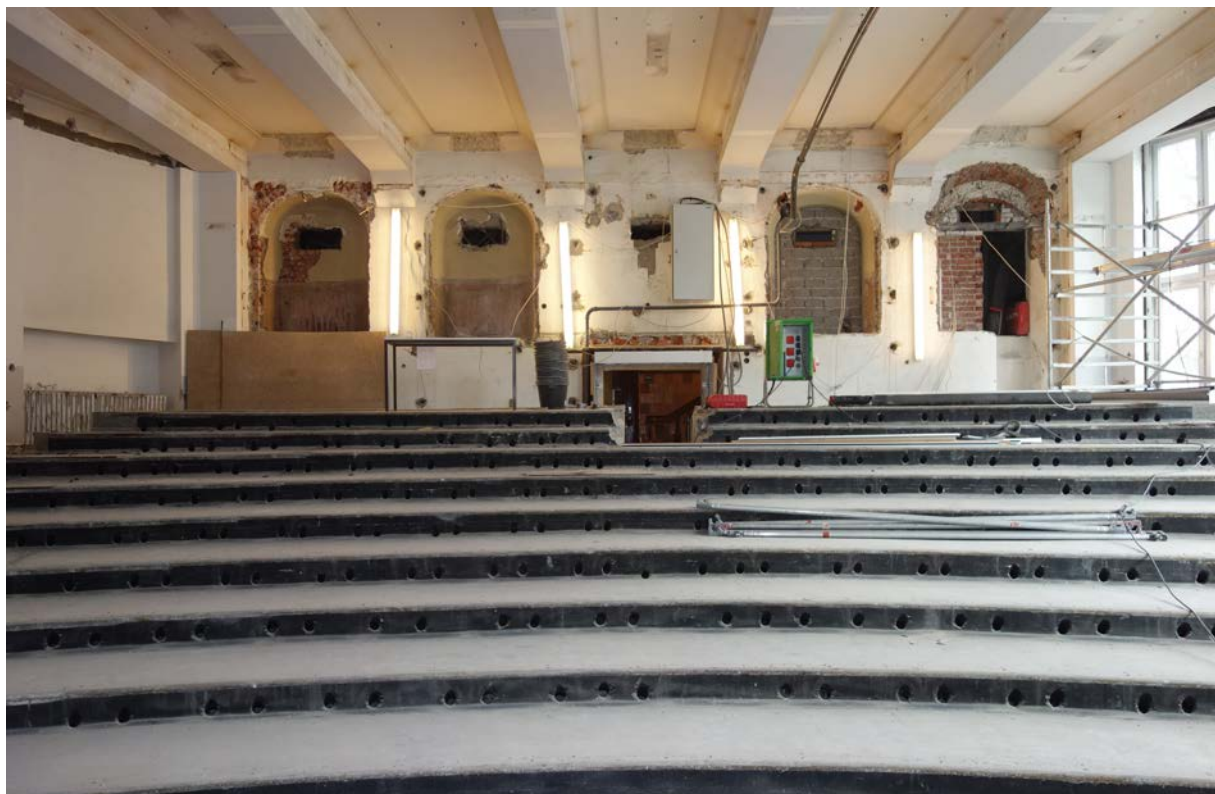
Entkernter Hörsaal: die Nischen an der hinteren Wand sind freigelegt und zeigen rechteckige Öffnungen für die in den 1950er Jahren eingebaute Belüftungs- und Klimatechnik. Die Stuhlreihen sind entfernt und die mit einer Terrazzo-Oberfläche versehenen Stufen freigelegt. Die abgehängte Decke ist abgenommen und in den Feldern zwischen den Tragbalken sind die originalen Oberflächenprofile wieder sichtbar.
