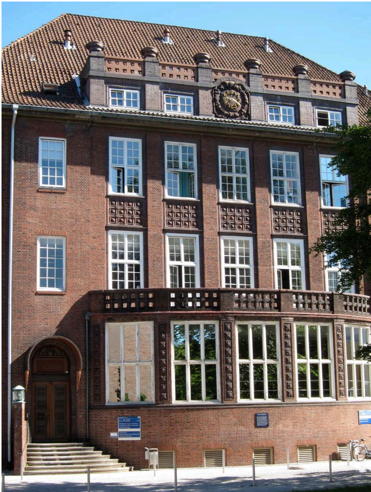
Die Front des Mittelbaus des dreiflügeligen Institutsgebäudes weist nicht nur an den Rahmen der Hörsaalfenster Terrakotta-Fliesen als Bauschmuck auf, sondern auch am Geländer auf der vorgebauten Fensterfront, als Keramikplatten zwischen den Fenstern der Stockwerke, gefaßt von Pilastern, und oberhalb der Traufkante des Dachs als Zierattika mit einer großen Uhr und urnenartigen Gebilden. Foto von 2007, vor der Restaurierung des Hörsaals.
