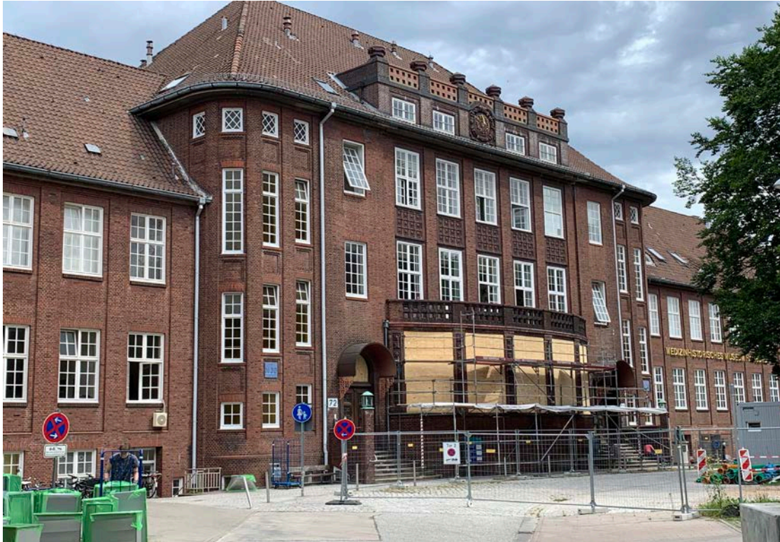
Die Hörsaalfenster sind ausgebaut und die leeren Fensterhöhlen bis zum Einsetzen der Bleiglasfenster mit Holzplatten verschlossen
