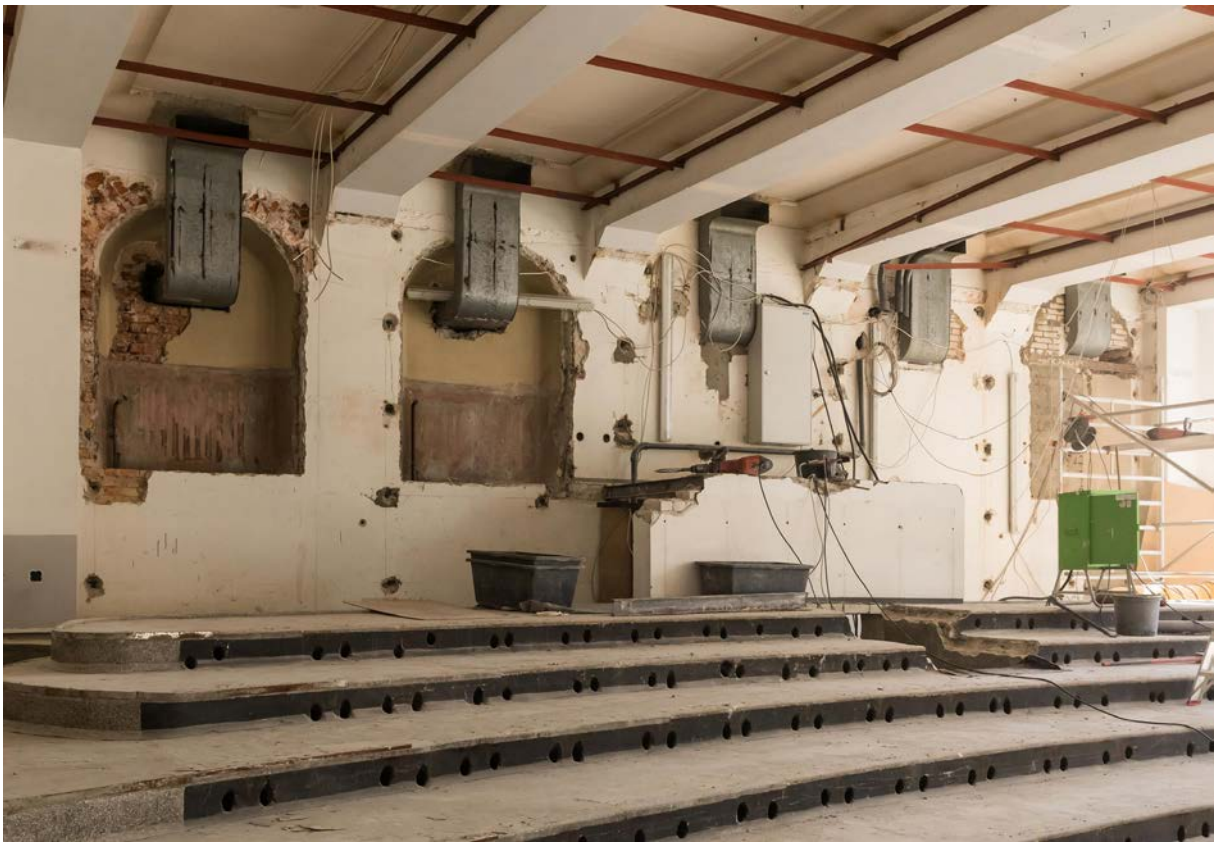
In den Wandnischen waren die aus Blech gefertigten Abluftkanäle des Hörsaals installiert. An den Stangen zwischen den Tragbalken war die abgehängte Decke befestigt. Alles wurde entfernt.
