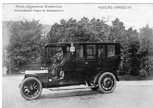
Abb. 5: Im Sommer 1906 zeigt Eppendorf stolz seinen neuen Elektro-Krankentransport-Wagen. Dessen von Ferdinand Porsche entwickelter Radnabenantrieb war eine technische Sensation. Leise surrte die in kleinster Serie hergestellte Mercédès-Électrique Ambulance über das Gelände.
