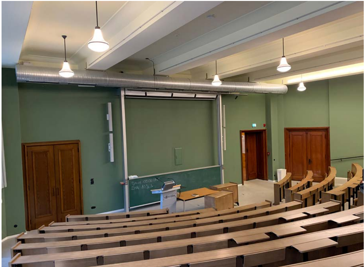
Tafelfront mit oberhalb der Projektionsfläche angebrachtem Abluftkanal als nicht verdeckte Metallröhre. Drei Türen: 1. linke Tür verdeckt Waschbecken, 2. Rechte Tür neben der Tafel ist Zugang zur Eingangshalle von N30, 3. Tür: Zugang zum Sektionssaal
