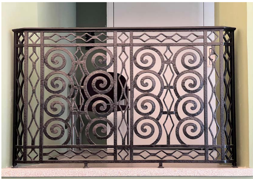
Die schmiedeeisernen Brüstungsgitter wurden nach alten Vorlagen perfekt nachgefertigt
