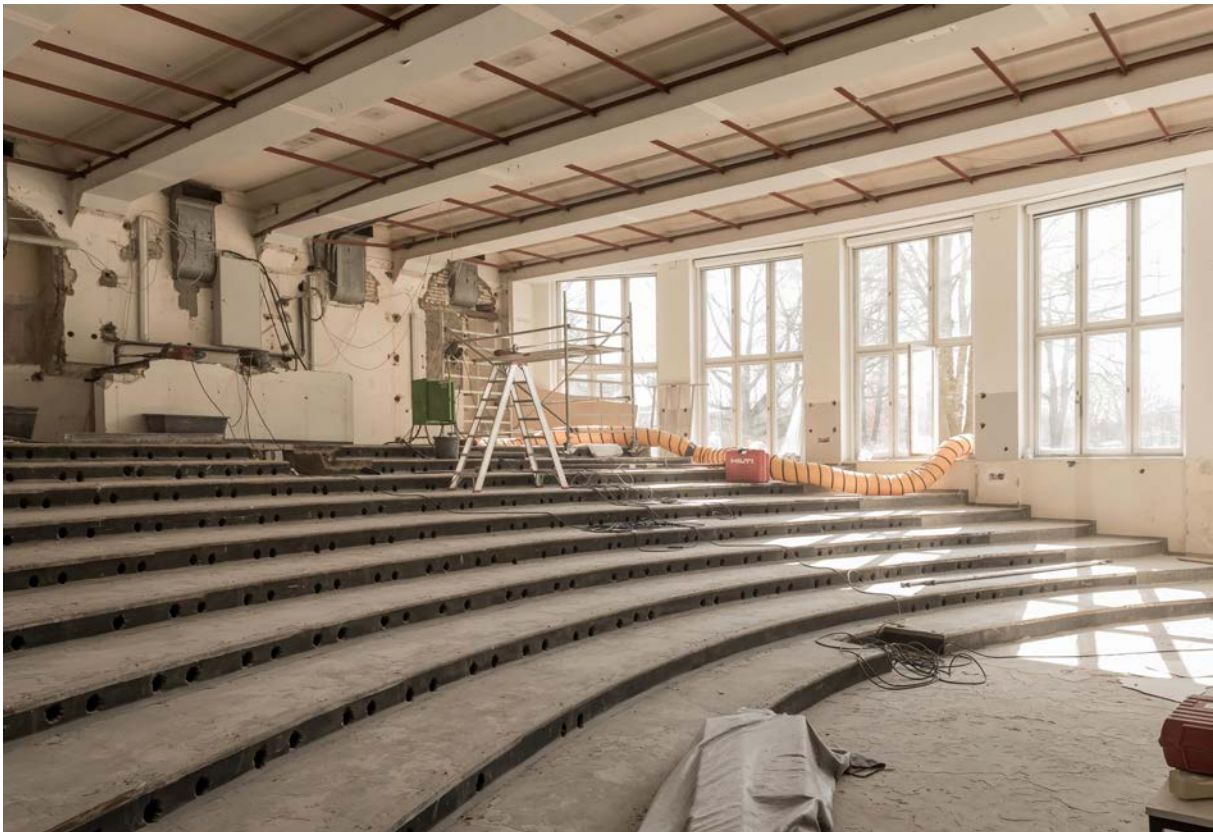
Leerer großer Hörsaal nach Ausbau des Gestühls, der abgehängten Decke und der Holzverplankung der Nischen
