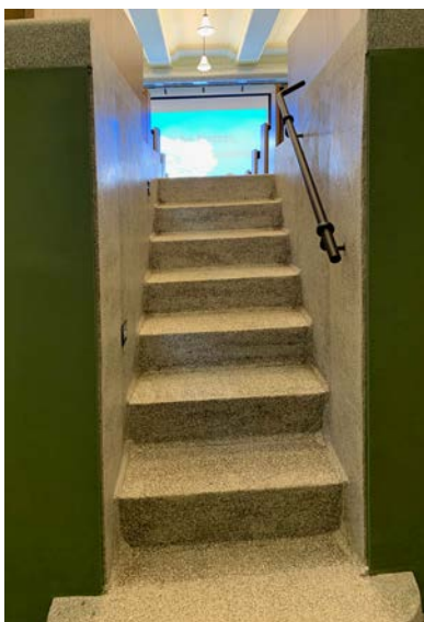
Mittlerer und seitlicher Treppenaufgang: Die Treppenstufen haben eine Terrazzo-Oberfläche
