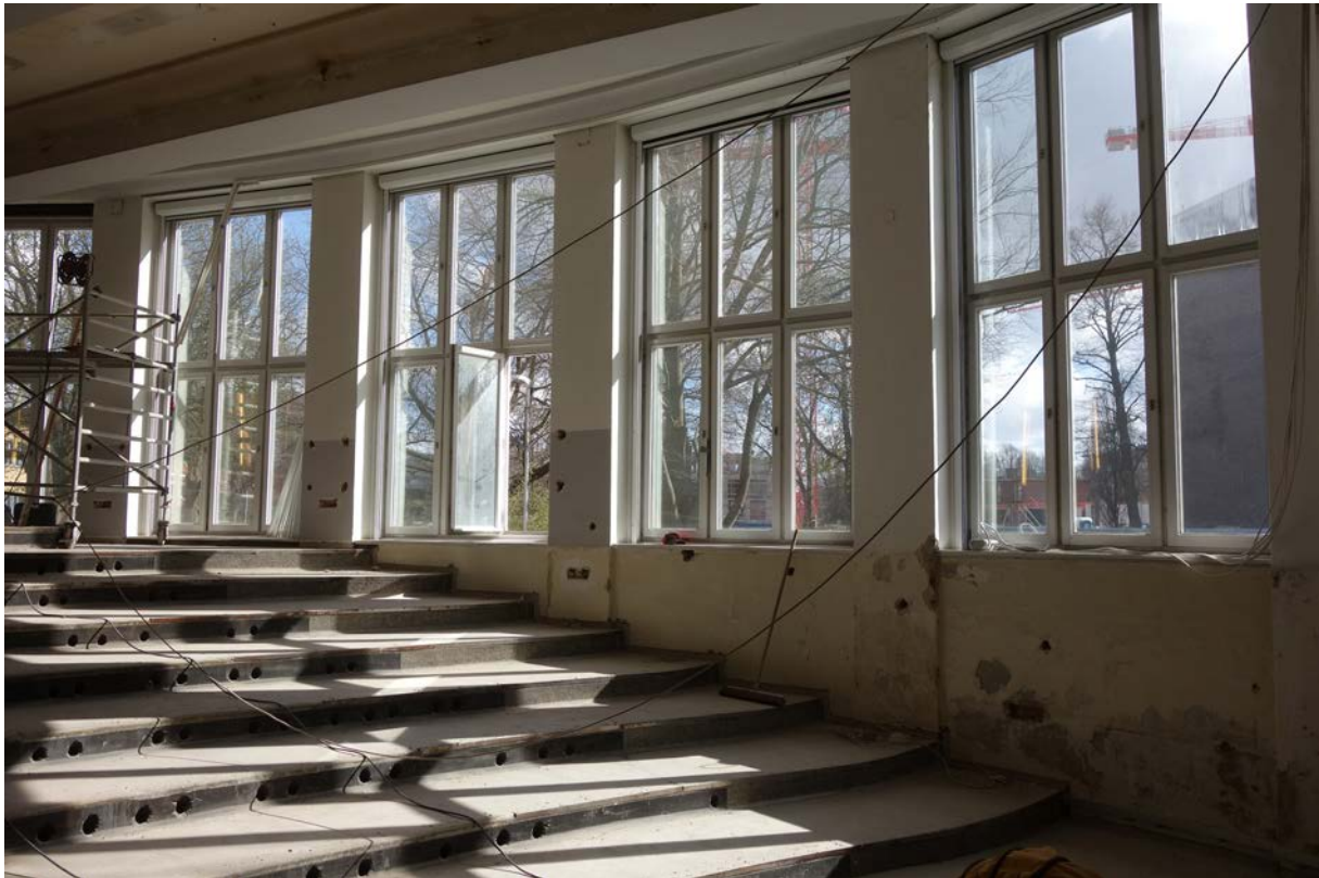
Die Holzrahmenfenster des großen Hörsaals sehen noch ganz gut aus. Die eingehende Untersuchung zeigt jedoch erhebliche Defekte an den Holzrahmen, die dringend einer Reparatur bedurft hätten.
