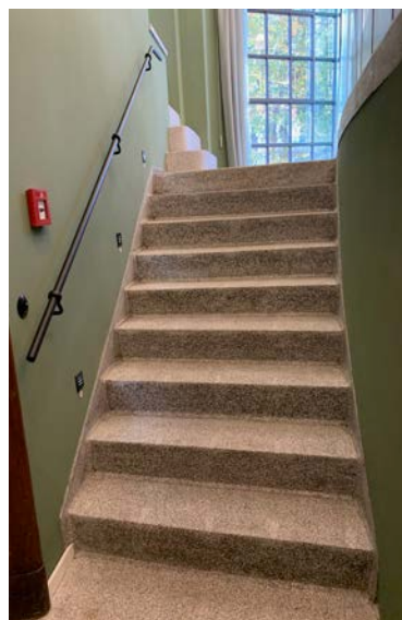
Mittlerer und seitlicher Treppenaufgang: Die Treppenstufen haben eine Terrazzo-Oberfläche
